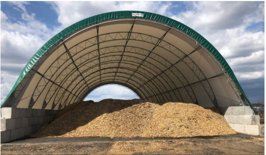
Figure 30. Cette installation de production de copeaux de bois de biothermic comporte une plateforme en asphalte afin d'éviter la contamination par le sable et la saleté, et garde les copeaux couverts afin de les laisser sécher. Elle stocke 1 000 tonnes anhydres. (Photo : Biothermic)
