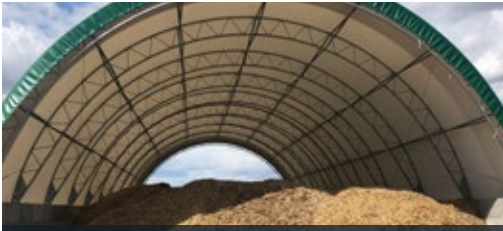
Figure 5. Cette installation de production de copeaux de bois pour la biothermie a une plateforme d'asphalte afin d'éliminer la contamination par le sable et la saleté et les copeaux sont couverts afin de permettre leur séchage. La capacité de stockage est de 1 000 tonnes anhydres. (Photo : Biothermic)
