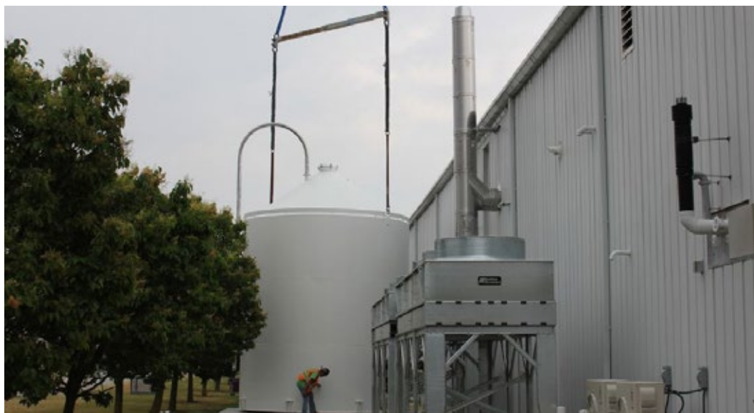
Figure 35. Un silo de 35 tonnes métriques est utilisé pour contenir les granules de bois au siège social canadien de Viessmann. (Photo : Viessmann Manufacturing Company Inc.)
