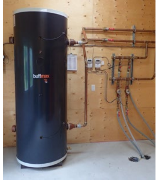
Figure 32. La chaudière et la trémie d'alimentation en granules (à gauche) alimentent en eau chaude le réservoir de stockage (à droite). L'eau chaude est ensuite fournie à Haliburton Solar and Wind et à Haliburton Highlands Brewing et sert au chauffage des locaux et de l'eau chaude domestique. On peut voir sur le mur les compteurs d'énergie utilisés pour facturer aux entreprises, à côté du réservoir de stockage.
