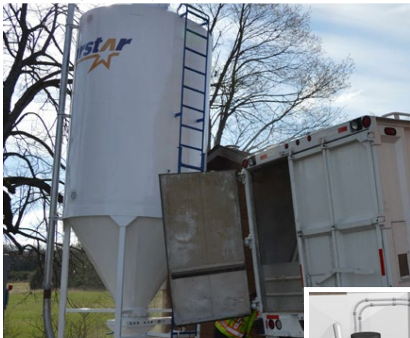
Figure 9. Camion de livraison déchargeant des granules de bois dans un silo agricole à l'aide d'un tuyau souffleur. Un système de commande automatique indique au système de combustion quand acheminer des granules de bois du silo à la trémie du système de combustion. (Photo : Biothermic)
