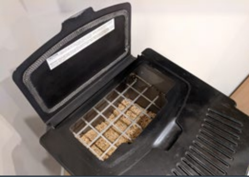
Figure 12. Les granules sont chargés dans la trémie du poêle à granules, comme illustré. Un système de commande achemine ensuite automatiquement les granules dans la chambre de combustion du poêle, au besoin. (Photo : Innovations Initiatives Ontario North)
