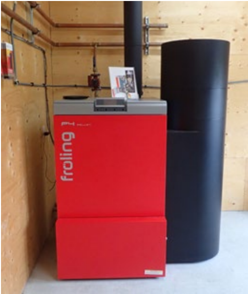
Figure 32. La chaudière et la trémie d'alimentation en granules (à gauche) alimentent en eau chaude le réservoir de stockage (à droite). L'eau chaude est ensuite fournie à Haliburton Solar and Wind et à Haliburton Highlands Brewing et sert au chauffage des locaux et de l'eau chaude domestique. On peut voir sur le mur les compteurs d'énergie utilisés pour facturer aux entreprises, à côté du réservoir de stockage.
