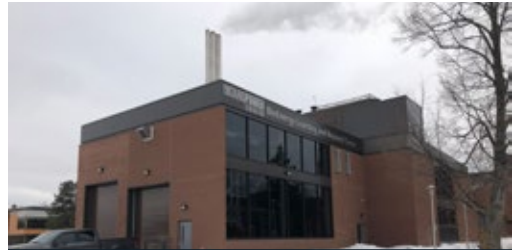
Figure 25. Installation de la chaufferie et du local de stockage du combustible du Confederation College. La porte de garage de gauche mène au local de stockage des copeaux situé sur place. La porte de droite mène à la chaufferie. Les passants peuvent voir le système par les grandes fenêtres. La salle des chaudières aux copeaux de bois n'a pas besoin d'être si grande, mais cette chaufferie a été conçue afin d'accueillir les groupes de visiteurs et de faire de l'enseignement. (Photo : Biothermic)
